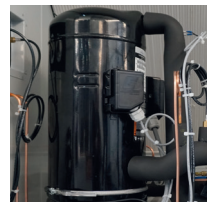
5 hocheffiziente Wärmepumpe optional invertergeregelt zur Umschaltung zw. Heiz- & Kühlbetrieb
